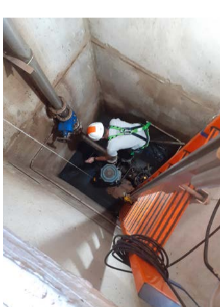
Contrôle d'un débitmètre et d'une sonde de niveau
